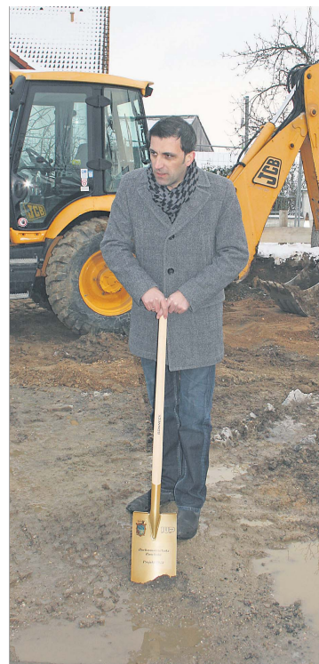
Keine Berührungsängste zeigte Bürgermeister Bernreiter. Der Gatsch der Baustelle hinderte ihn nicht, den Spatenstich durchzuführen.
